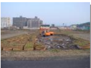
ユニットを形成し トラックで運搬する
